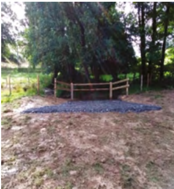
ABREUVOIR AU COURS D'EAU - POSE DE CLOTURES
